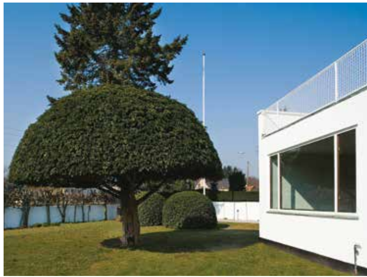
Til venstre: Hjørnevinduer af stål med lodrette sprosser. Her fra husets østfacade.
