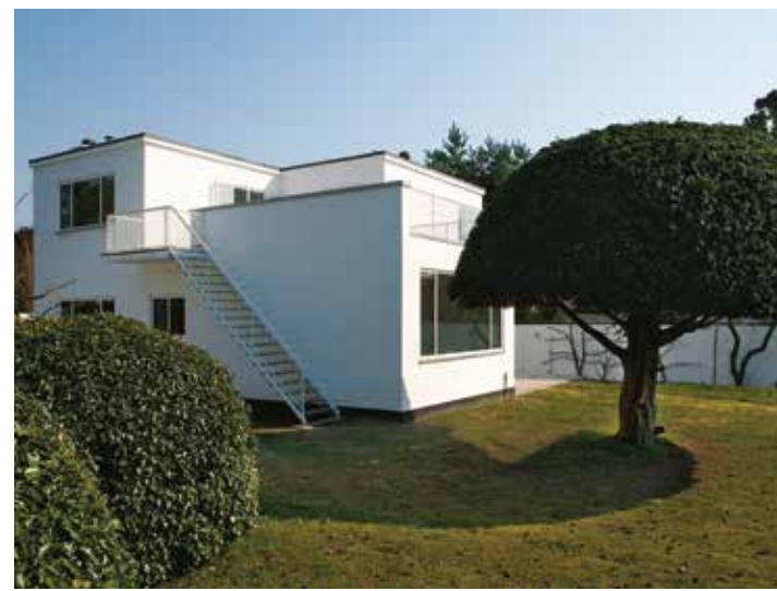
Til venstre: Husets vest- og sydfacade med ståltrappen til tagterrassen. Huset fremstår ikke som et isoleret objekt, men som en række udsnit af en større sammenhæng. Hertil hører ikke mindst haven, der fletter sig sammen med huset. Eksempelvis griber et langt bed langs den hvide havemur fat i husets ene side, mens havens planter andre steder klatrer op af husmuren.
