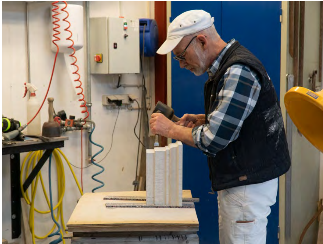
Reparation af sandsten fra Digegrevens Hus i Tønder.
