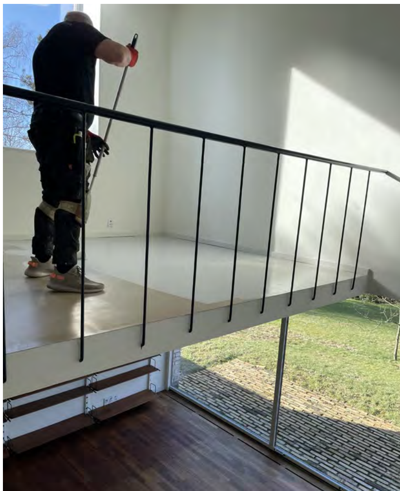
Slibning af gummigulv i ingeniør Varmings eget hus i Gentofte.
