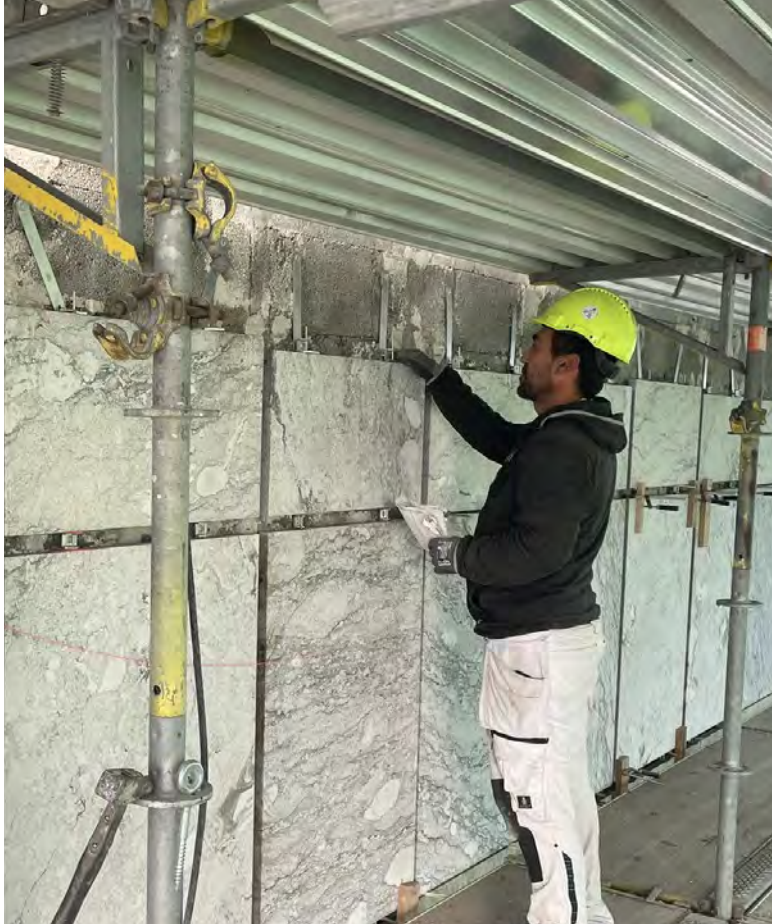
Udskiftning af marmorfacade på kontorhøhuset på Jarmers Plads i København.
